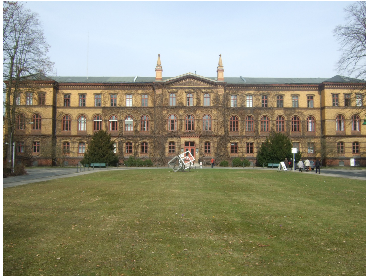
Ort: Vivantes Netzwerk für Gesundheit GmbH, Gebäude der Geschäftsführung
